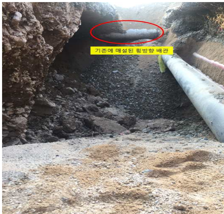
[사진2] 횡방향 배관 매설 전경(기존 매설배관의 영향으로 붕괴에 취약)
