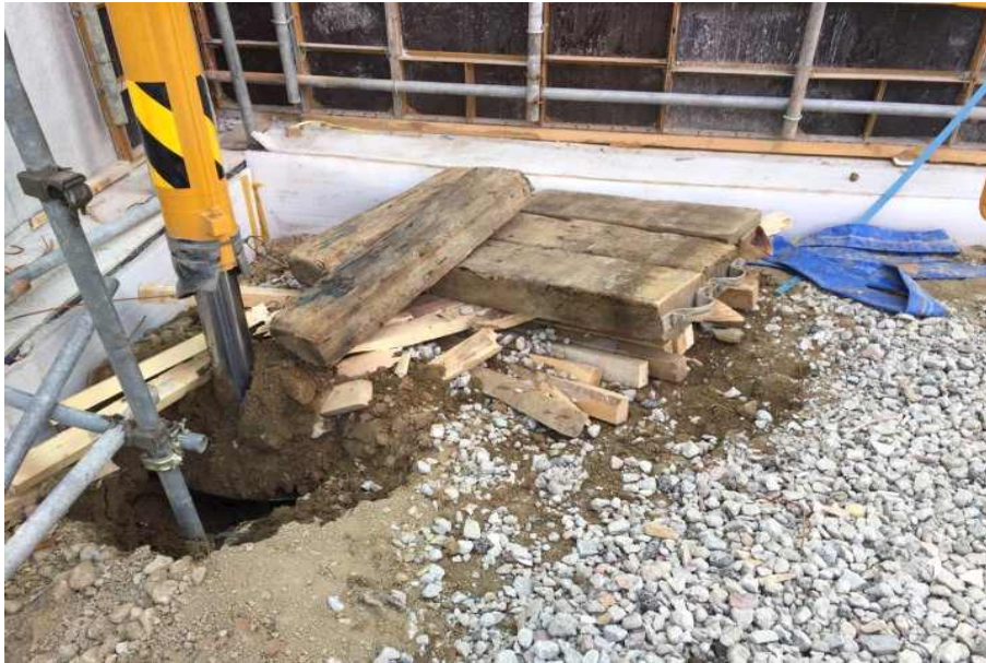
[사진1] 재해 직후 아우트리거 상태
