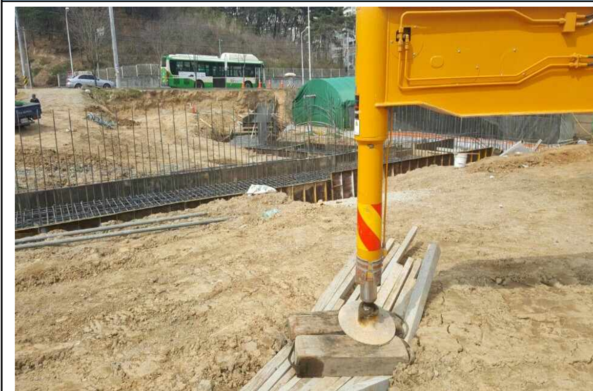
[사진2] 좌측 아웃트리거 설치 지반 침하상태
