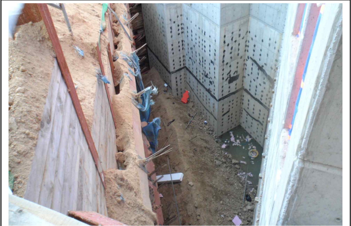
[사진2] 재해발생 지점인 흙막이가시설 해체구간 모습
