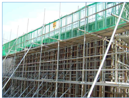
〈그림11〉 안전난간대 설치
