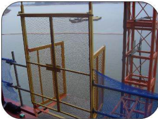
<그림 7> 상부 이동 건설용 리프트
