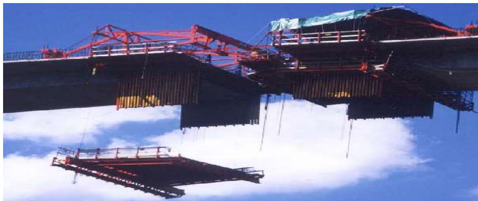
<그림 16> 키 세그먼트 거푸집 설치
