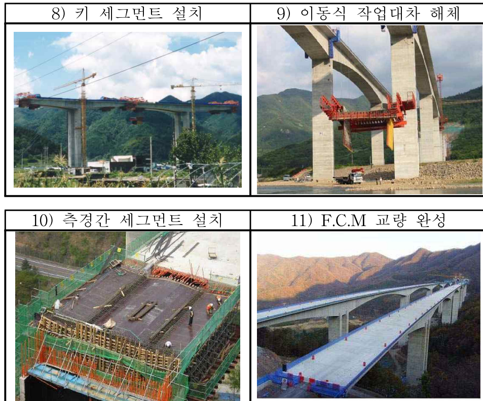
<그림 4> F.C.M공법의 시공순서 사진
