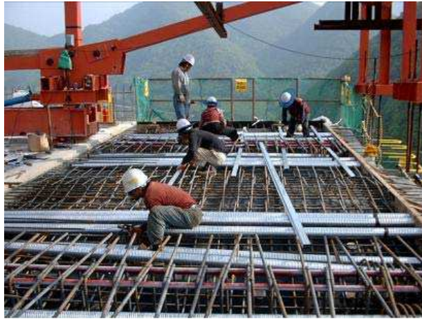
<그림 17> 세그먼트 철근조립 및 쉬스관 설치
