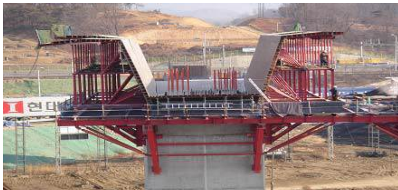
<그림 9> 주두부 브라켓에 설치된 거푸집
