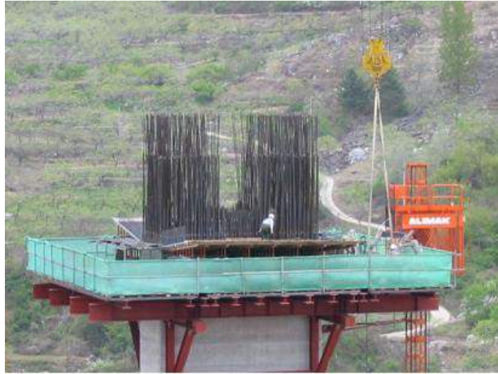
<그림 8> 주두부 브라켓에 작업발판 및 안전난간
