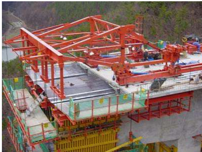
<그림 14> 이동식 작업대차 이동
