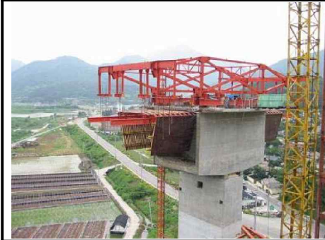
3) 이동식 작업대차 설치
